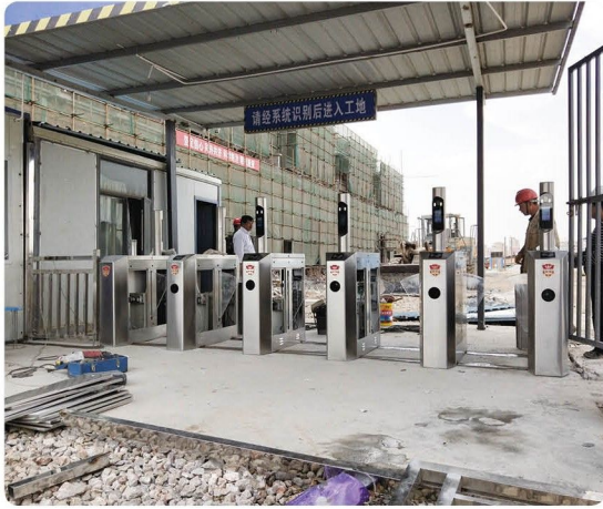
曲靖湖畔家园工地
